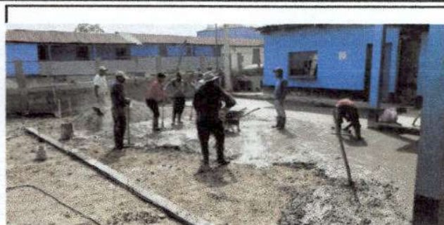
losa del patio de la escuela
