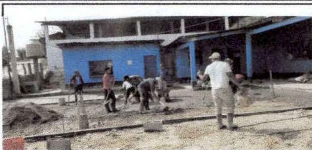
construccion de piso
