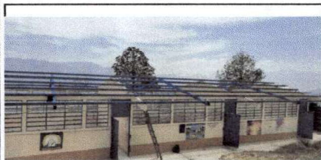
cambio de estructura de techo
