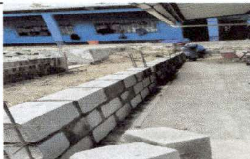
construccion de muro
