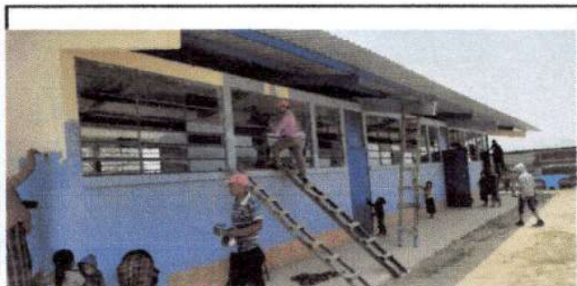
pintado de las aulas
